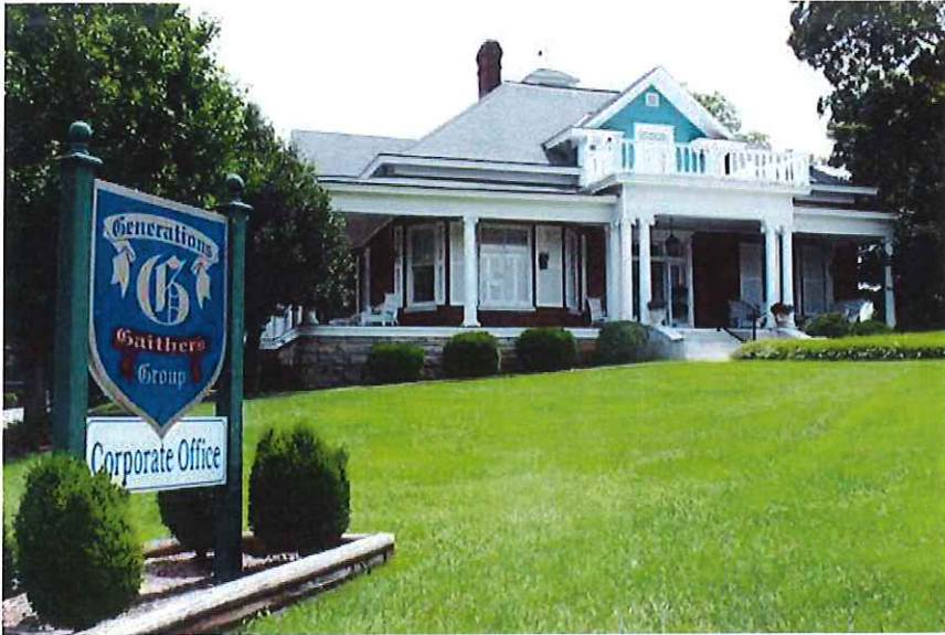
Corporate Office 406 N. Spring St. McMinnville, TN 37110
